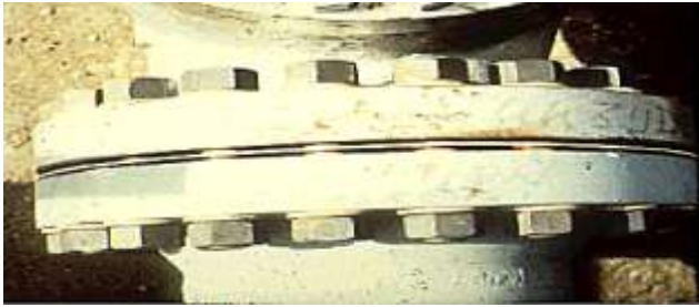
Fig. 2.4 Crevice corrosion
