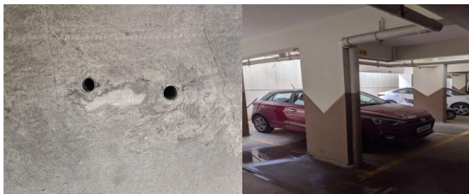
Fig -3: PVC conduit
